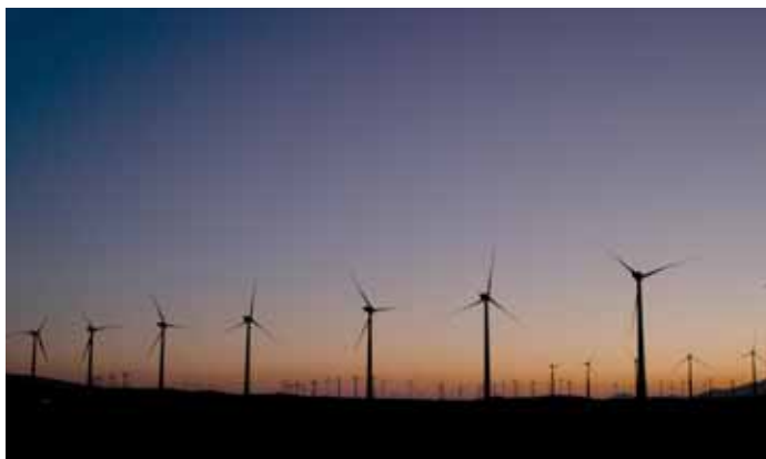
Il costo per impianti di potenza tra i 10 e i 20 kilowatt varia dai 2mila ai 2.500 euro per kilowatt installato. Dal Conto energia è possibile usufruire di 0,30 euro/kWh per 15 anni
