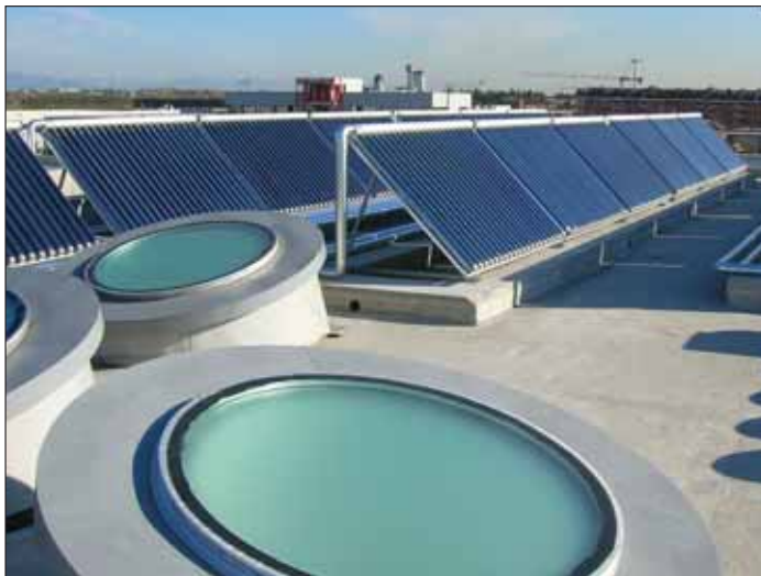
Un particolare del campo solare installato sul tetto dell'impresa Bertolazzi di Concorezzo, in provincia di Milano: qui l'energia del sole scalda gli impianti d'inverno e li rinfresca d'estate grazie a un assorbitore che sviluppa 30 kilowatt da un campo di soli 100 metri quadrati
