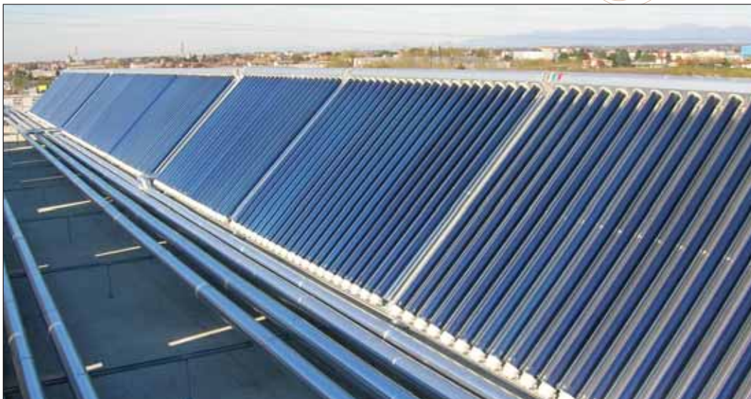
Un particolare del campo solare installato sul tetto dell'impresa Bertolazzi di Concorezzo, in provincia di Milano: qui l'energia del sole scalda gli impianti d'inverno e li rinfresca d'estate grazie a un assorbitore che sviluppa 30 kilowatt da un campo di soli 100 metri quadrati
