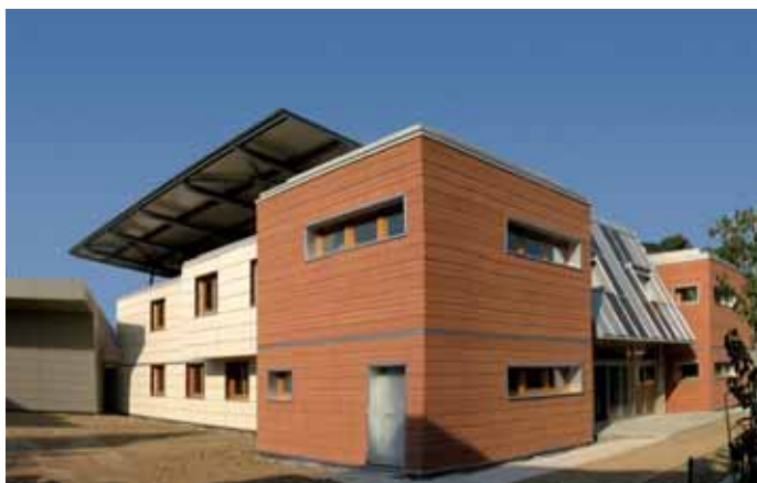
La comunità di recupero di Lodi utilizza tecnologie leggere, stratificate a secco. In collaborazione con il Politecnico di Milano sono stati qui sperimentati nuovi prodotti per struttura e facciata. Il risultato è un edificio con un fabbisogno energetico residuo invernale di 24 kWh per metro quadrato per anno
