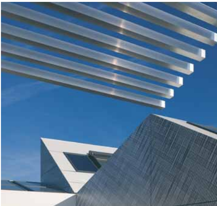
Dieci metri quadri di pannelli solari sono stati abbinati a un serbatoio di acqua in grado di accumulare 700 litri. Questa è la base per la climatizzazione estiva gestita mediante una pompa di calore che attiva un ciclo di condizionamento termodinamico frigorifero collegato al sistema di climatizzazione aria
