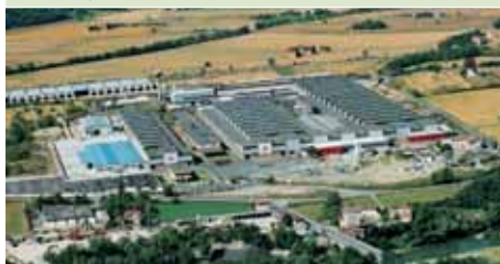
Lo stabilimento Kme di Serravalle Scrivia (Al) utilizzerà il 5% dell'energia fotovoltaica prodotta
