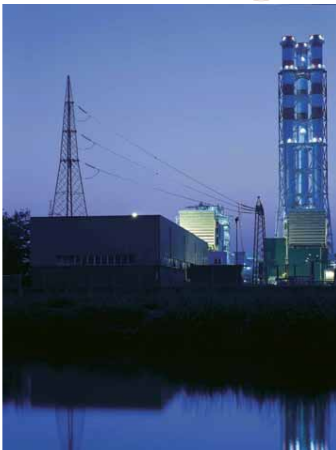
La centrale elettrica a ciclo combinato di Endesa Italia. La società (posseduta all'80% da Endesa Europa e al 20% da A2A) ha cinque centrali e con le due idroelettriche e i parchi eolici ha una potenza installata di 7.022 MW
