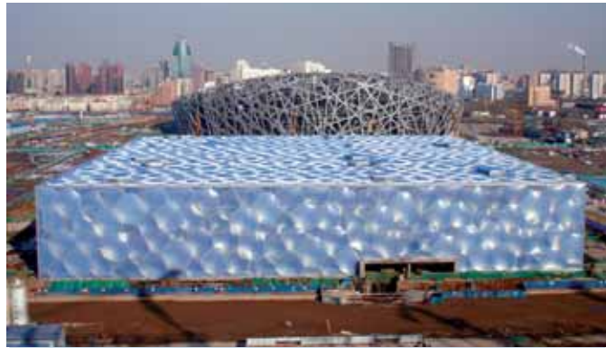
Una veduta dall'esterno del Water Cube dove si svolgeranno le gare di nuoto, nuoto sincronizzato, tuffi e pallanuoto. La struttura di 177 metri di lunghezza e 31 metri di altezza occupa una superficie di 70mila metri quadrati ed è in grado di accogliere 17mila spettatori. L'aspetto del centro acquatico è quello di un cubo di molecole d'acqua. La pelle dell'edificio è composta da una miriade di cuscinetti gonfiabili costituiti da una doppia membrana di un materiale plastico leggero e trasparente usato nell'industria aerospaziale. Il progetto è stato realizzato da due studi di architettura australiani e uno cinese ed è costato 67,5 milioni di euro
