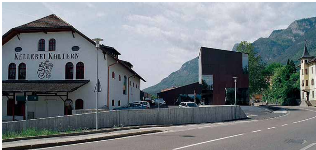
Il wine center di Caldaro, Comune di 7.200 abitanti, coniuga tradizione vinicola locale ed energia da fonti rinnovabili. È alimentato con un sistema geotermico: dal sottosuolo si prende il calore necessario per riscaldare l'edificio in inverno e rinfrescarlo in estate
