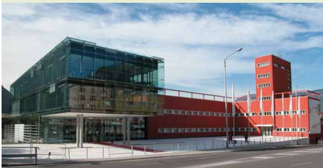
L'Accademia europea di Bolzano dispone di unità trigenerativa per l'approvvigionamento termico ed elettrico e vanta un impianto di raffrescamento solare con macchina ad assorbimento. Ospita anche un impianto solare termico e un impianto fotovoltaico da 4 kW
