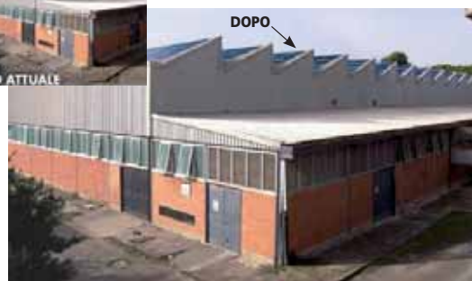
L'immagine mostra un progetto finanziato con lo stanziamento della regione Sardegna. Nel caso specifico, l'edificio, ex Cisapi, sarà in grado di produrre 462 kW (24 sottoimpianti da 19,25 kW)
