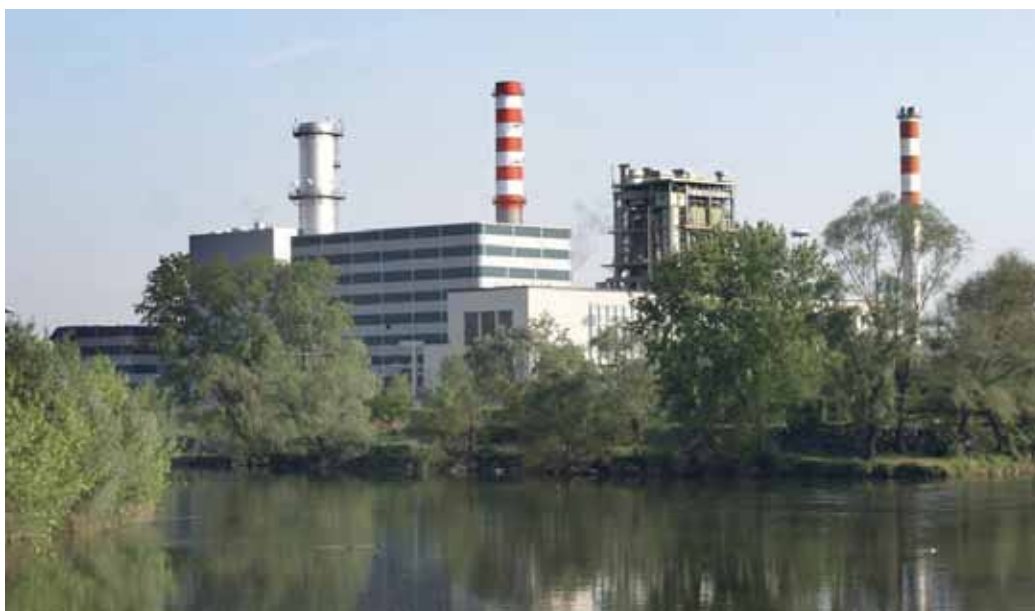
La centrale di Moncalieri (qui una veduta) fornisce acqua alla temperatura di 120° alla rete di teleriscaldamento della città di Torino Sud e Centro
